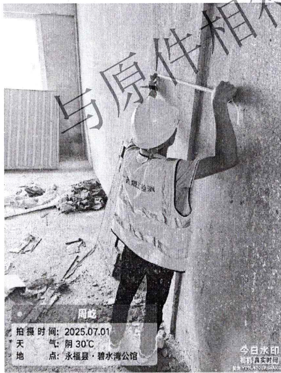
附照片 2-3 柱构件尺寸检测现场照片
