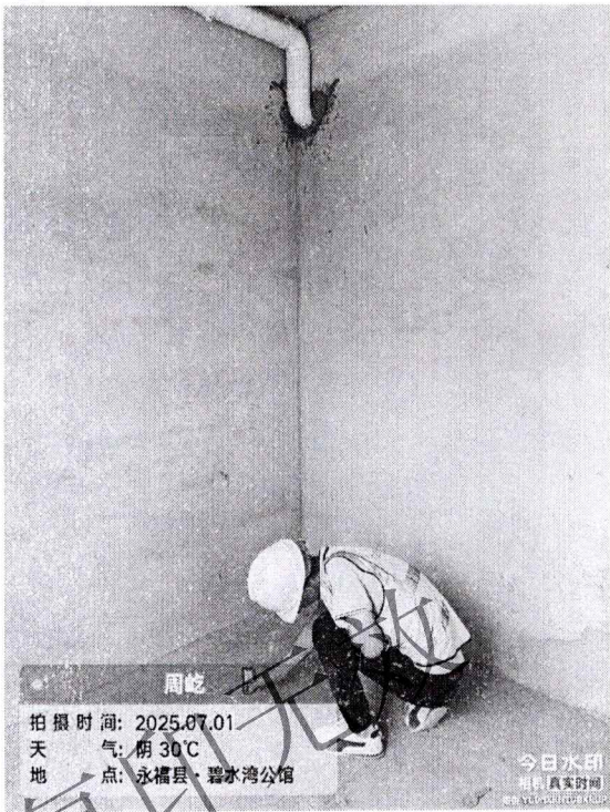
附照片 2-2 层高检测现场照片
